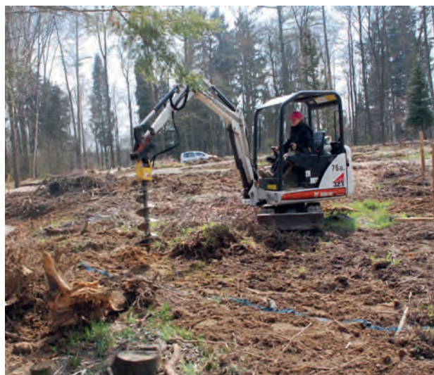
Abb. 31 Lochbohrung mit Kleinbagger
